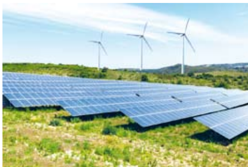
Рис. 38. Солнечные панели и ветроэнергетические установки
