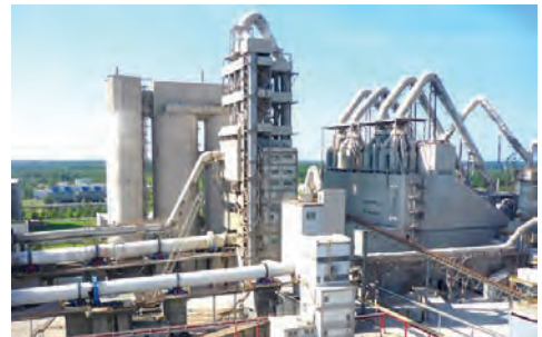
Рис. 123. Белорусский цементный завод, г. Костюковичи
